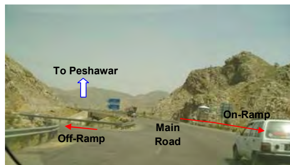
N.W.F. Road IC (Sta.19+088)
