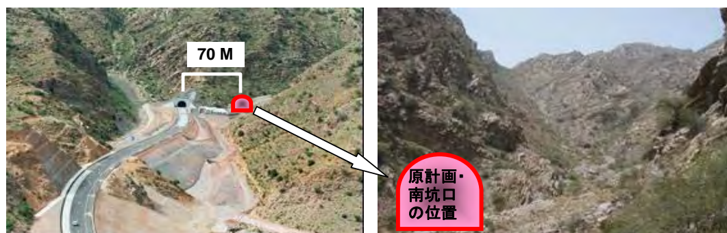
トンネル南坑口の全景
