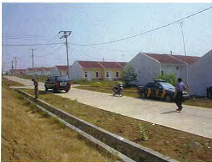
電界強度測定状況
