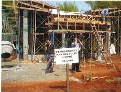
方位確認状況
