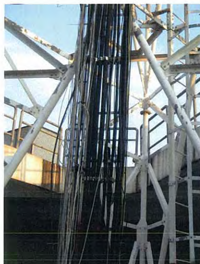
BEJ 同軸ケーブル布設状況
