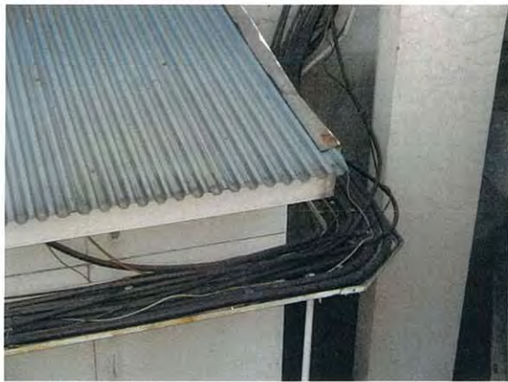
BEJ 同軸ケーブル布設状況
