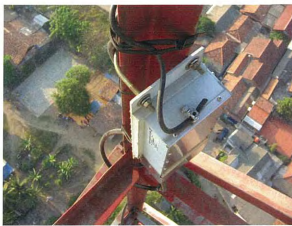
CIKARANG 受信トップアンプ取付状況
