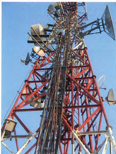
BEJ 同軸ケーブル布設状況
