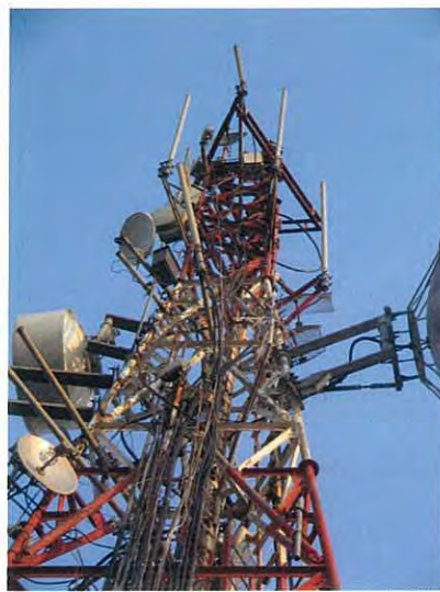
BEJ 空中線取付 同軸布設状況
