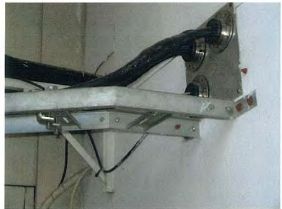
BEJ 同軸ケーブル布設状況
