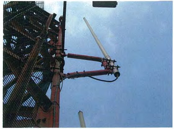
BEJ 空中線取付状況
