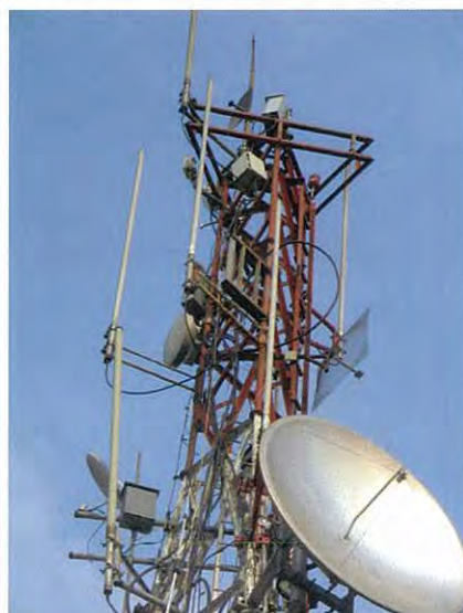
BEJ 空中線取付状況
