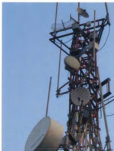
BEJ 空中線取付状況
