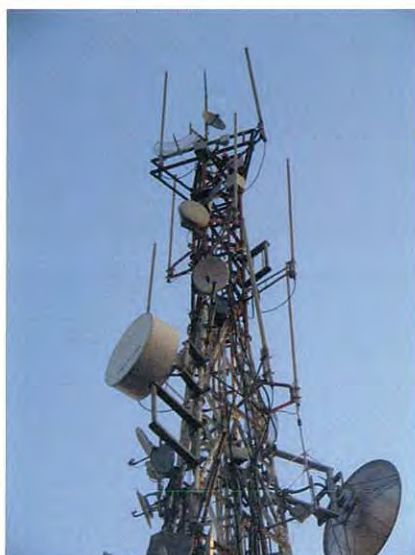
BEJ 空中線取付状況
