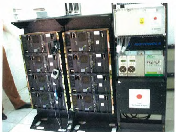
CIKARANG 機器据付状況
