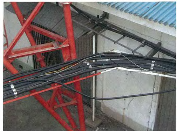
BEJ 同軸ケーブル布設状況
