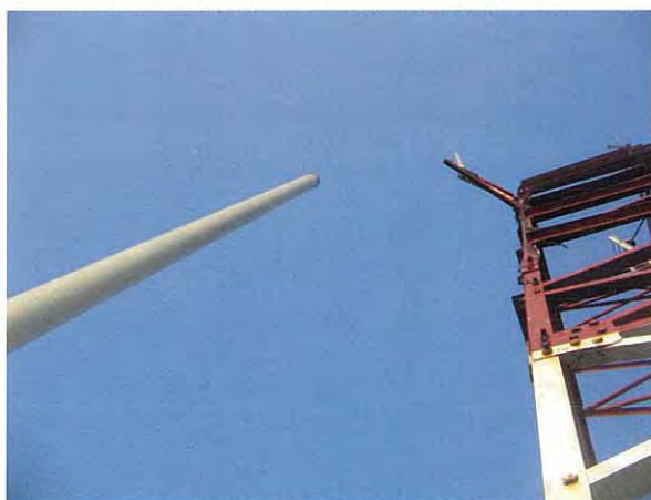
CIKARANG 空中線取付状況
