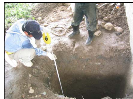
Foto 2.2.2-3 Confirmando la Posición de la Base del Estribo
