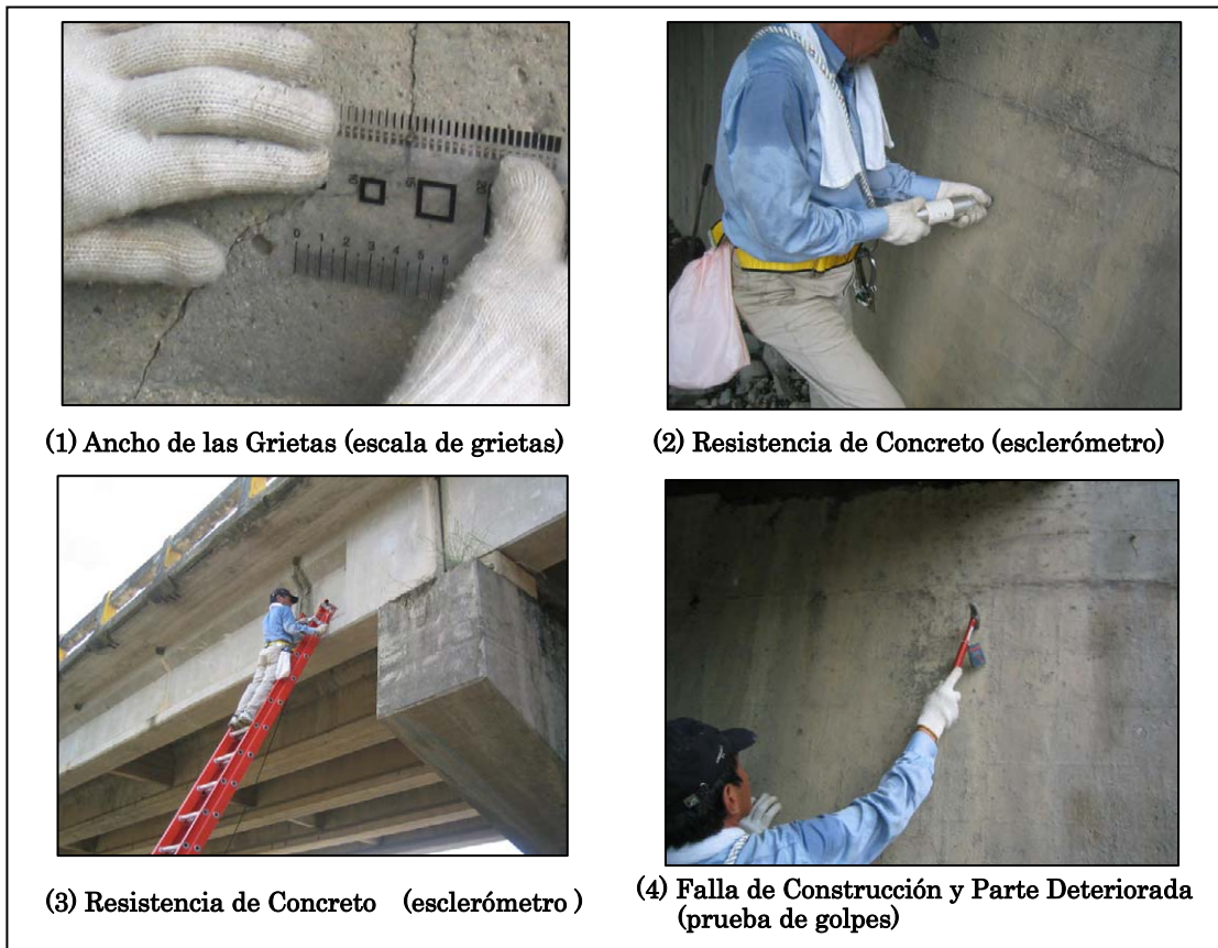
Foto 2.2.2-4 Estudio de Seguridad de Elementos y Materiales del Puente
