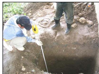
写真 3.2.2-3 床付け面の確認状況
