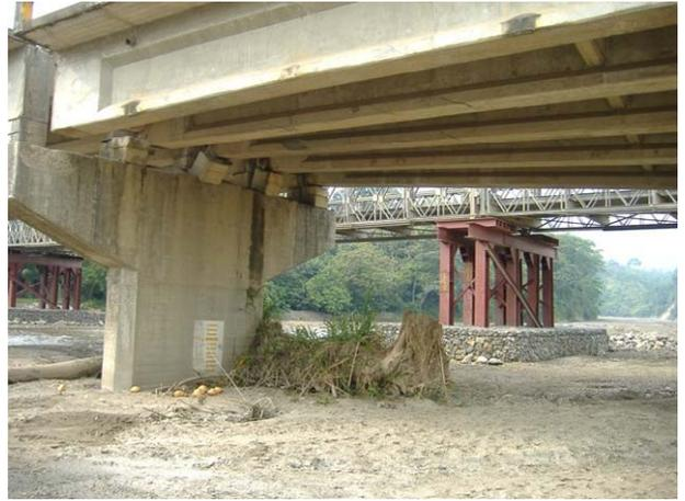
P1 橋脚の変位によって第二径間の P2 橋脚上の嵩上げしたコンクリートブロックが外れている
