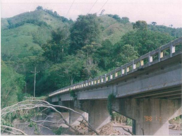
ハリケーン「ミッチ」による被災で橋脚が沈下して上部工が折れ曲がった状態（1998年当時）
