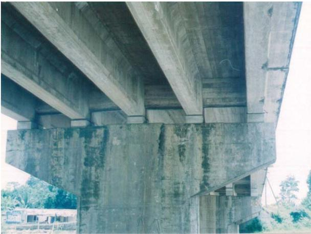
コンクリートブロックを挿入して上部工の嵩上げにより平坦性を確保（2001年当時）
