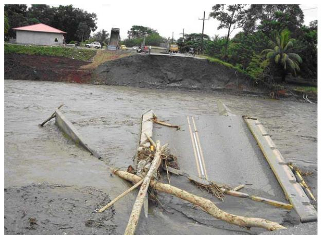
水位が低下した後の橋台翼壁と上部工第一径間及び侵食された左岸の状況（2005年当時）
