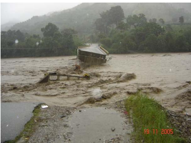
ハリケーン「ガンマ」による被災で橋台と上部工第一径間が流出した直後の状況（2005年当時）
