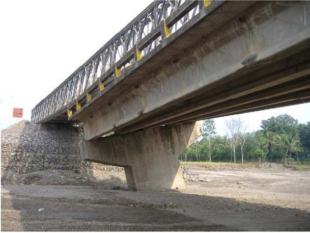
被災して大きく上流側に傾いた P1 橋脚の状況
