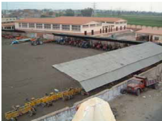
現ダマンフル農業機械化ステーション： 全周囲はフェンスで囲われており、写真手前側は 前面道路に面している。
