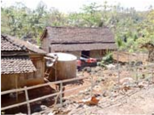
各戸にある雨水貯水タンク
