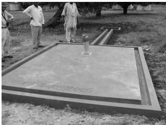
小学校のPTAの資金でDGH/SHが現地掘削業者を使って建設した井戸（2006.9.15完成）。手押しポンプを設置する予定。
