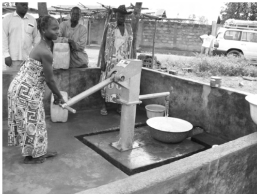
第5次村落給水で設置された手押しポンプ井戸 井戸深度約60m、水量は十分（1999年設置）
