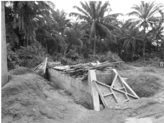
村の入り口で建設中の横断暗渠
