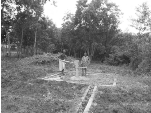
手押しポンプは故障しており使用不能。 ポンプと揚水管の接続が悪く、ポンプが 井戸の中に落ちている、とのこと。
