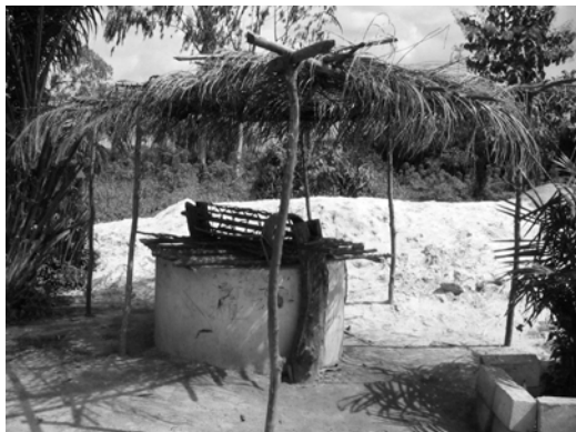
既存の掘り抜き井戸
