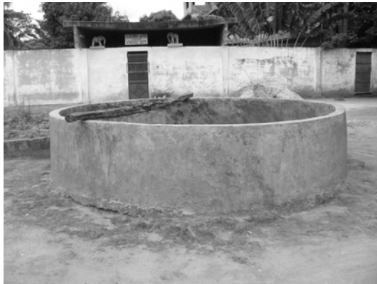
雨季に雨水を貯めて使用するタンク
