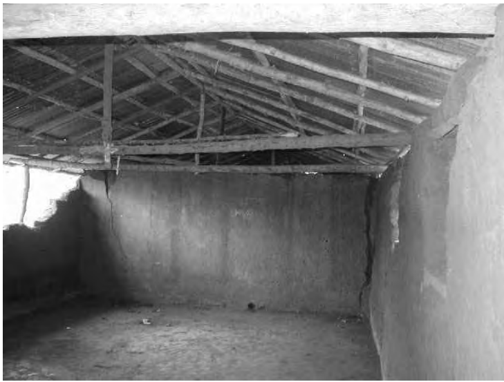
CUFFO 県 TOVIKLIN 市 TOVIKLIN 区 ATCHANVIGUEME 小学校 バンコ造教室の内部 2006年9月25日撮影
