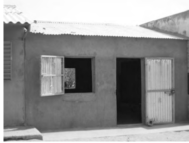
既存教室棟(教室間に保護者会で建てられた教室)
