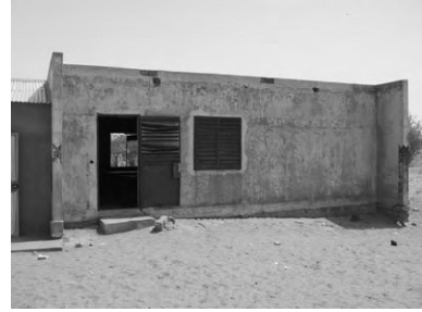
既存教室棟(建替対象)
