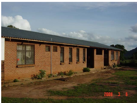
ルンビ県ムジシヘルスセンター 1981年公共事業省(当時)により承認された標準設計により建設された、外来棟と産科棟が合併タイプ。
