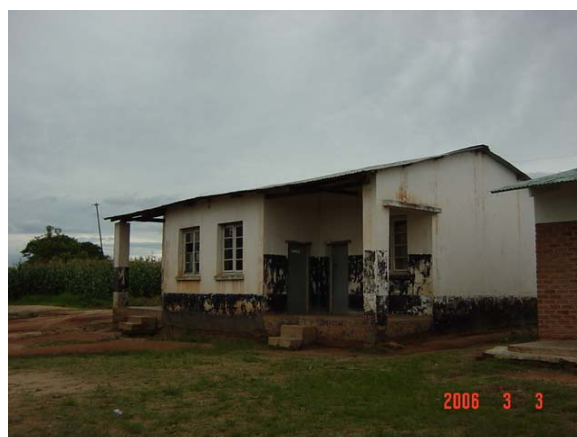
ムジンバ県カフクレヘルスセンター外来棟 1964年築。延べ床面積約80㎡と規模が小さい。メンテナンスとして外壁のペイント補修が行われていない。
