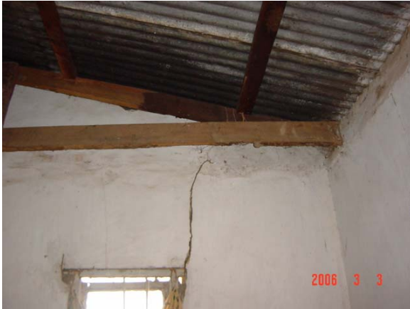
ムジンバ県カフクレヘルスセンター外来棟 母屋材にシロアリ被害があり、駆除が必要。
