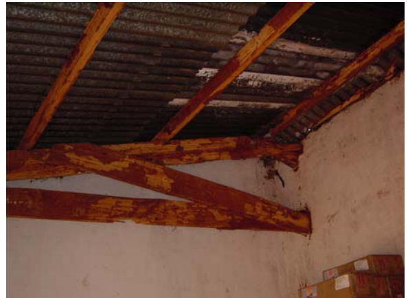
カスング県コラヘルスセンター 築 30 年以上経過した建物のため、老朽化が激しく、一 部屋根が強風と飛ばされ修理を行った。
