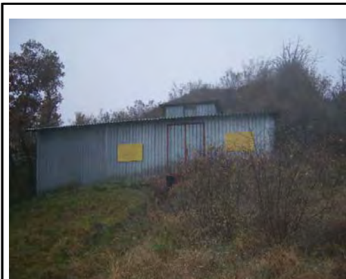
プロジェクト・サイト周辺 古墳調査及び侵入防止のため羨道が保護されている。劣化防止や壁面の保護等のために内部を一般公開出来る状況にない。
