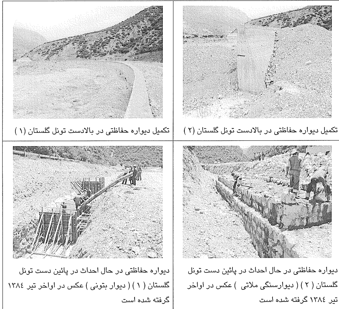
شکل ۲-۱۰۴ عملیات احداث جاده در دست اقدام در پارک ملی گلستان
