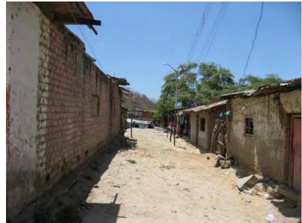
写真-4: プロジェクトの実施によって移転が必要となったペ国側家屋。
