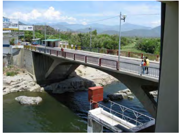
写真-2: 下流側から見た現マカラ橋の側面。
