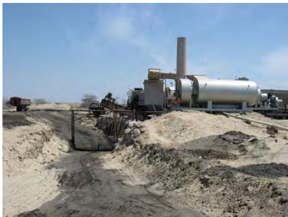
写真-11: Yaguesa 社の稼働中のアスファルトプラント(ペ国ピウラ市から北方約 20km の国道脇に位置する)。
