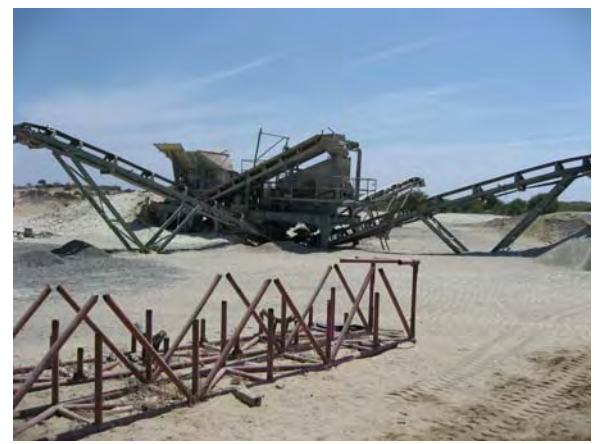
写真-12: Yaguesa 社の稼働中の砕石プラント(ペ国ピウラ市から北方約 20km の国道脇に位置する)。
