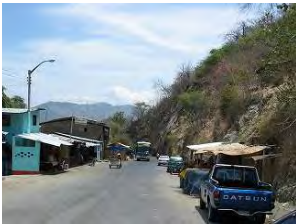
写真-3: ペ国側現橋取付道路の状況(写真右側の岩斜面を本工事で掘削する)。
