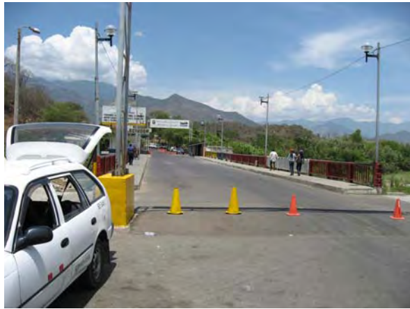
写真-1: 現マカラ橋の橋面の現況。
