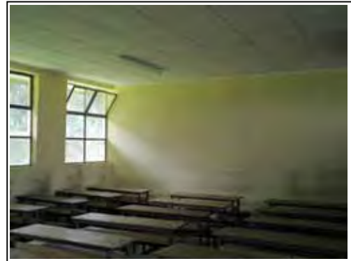
天井・照明設備も設置された教室内部 同左
