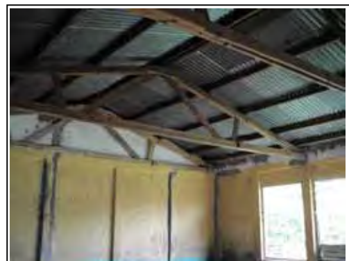
製材規格品による木造トラスと天井不設置教室 同左
