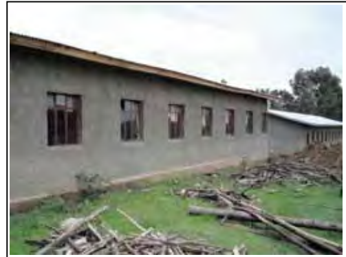
スタンダード仕様には稀なガラス窓の校舎 東アルシ県クルサム小学校（8 学年）
