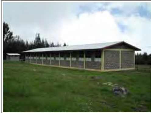
2004 年度案件の建設校舎 北ショワ県フィッチェ小学校（8 学年）
