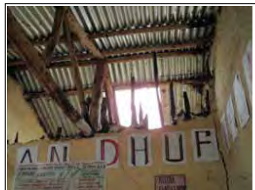
施工途中のような教員室内部 同左
