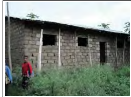
建設中のアドピ（日干レンガ）壁校舎例 東ショワ県ハウスマルカーサ小学校（8 学年）
