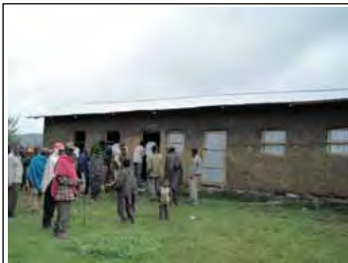
典型的な住民参加による建設校舎例 北ショワ県ガダシャノ小学校（8 学年）
