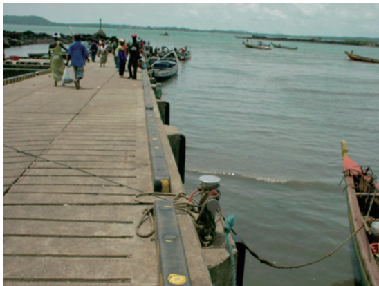
写真3 平均水面時の棧橋全面
