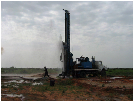
新設井戸。井戸洗浄中(エアーフット)
