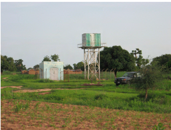
動力式深井戸。現在は故障中で復旧の目途は立っていない。
