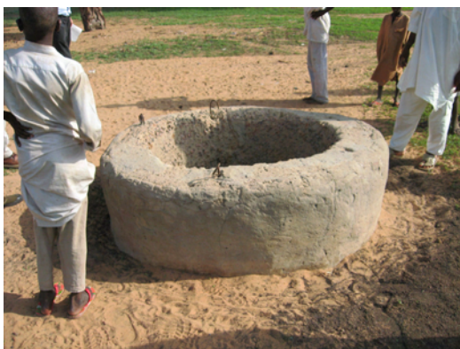
セメント井戸 (汚染防止掘抜き井戸)
