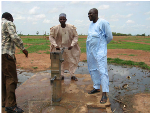
Fune 郡、Garin Bengel 村のハンドポンプ深井戸。井戸深度 48m、地下水位 15m。
