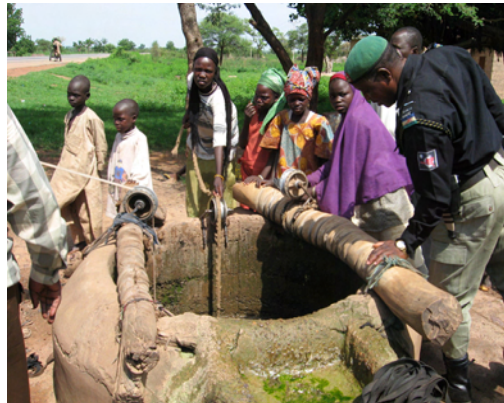
Fune 郡、Gununu 村の掘抜き井戸。かつてはハンドポンプが据え付けられていたが、1人しか使用できないので住民が撤去した。
