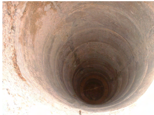
ナイジェリアにおいて Cement Well と呼ばれている井戸。ヨベ州では安全な水として給水率にカウントされている。
