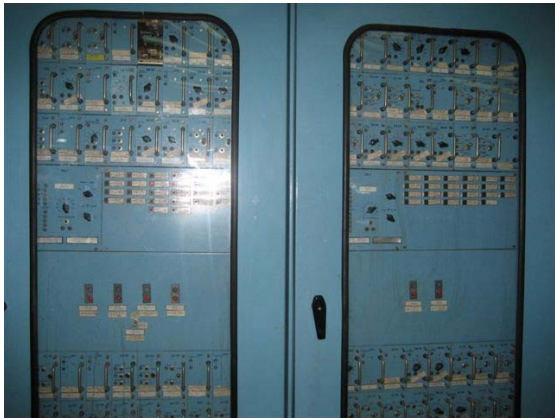
タービン保護リレー盤（ロシア製）
