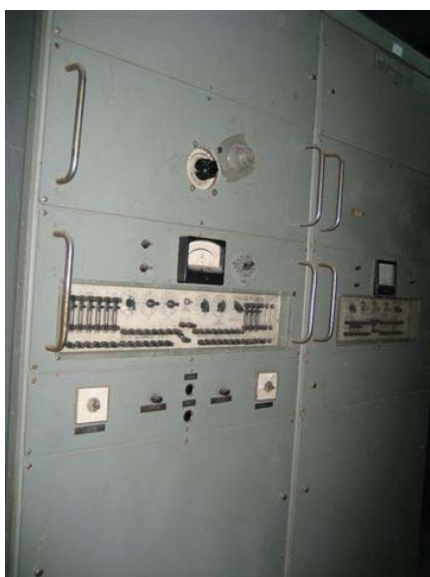
AVR 盤（ロシア Elektro Sila 社製）
