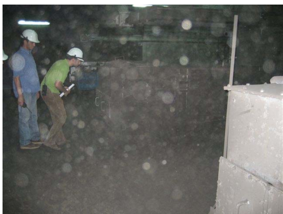
ボイラ建屋内塵埃
