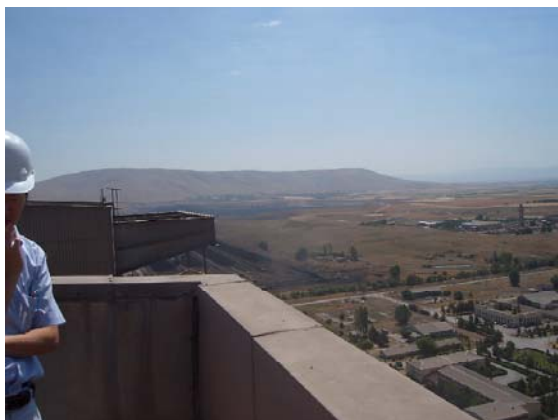
ボイラ建屋屋上からの遠景 (黒い部分は石炭採掘場か)
