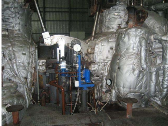
高压タービン（右）油圧（サーボ）系部分改造
