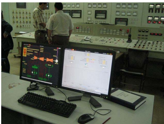
Primary Frequency Control 用モニター（Scoda） タービン及び一部ボイラデータ監視
