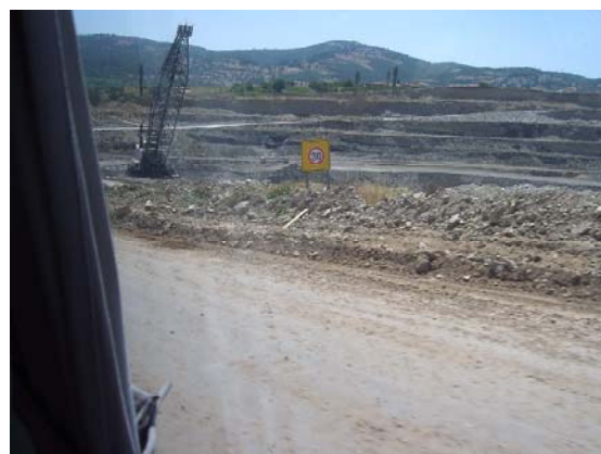
炭鉱：露天掘りであるが、数年前に大規模な土砂崩れがあり、現在の採掘量 50 万 T/年に対して、500 万 T の表層土砂を撤去している。
