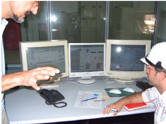
脱硫装置操作用 CRT
