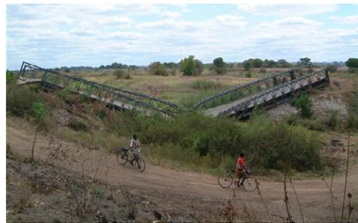
写真 2-9 重積載車によって落橋している様子
