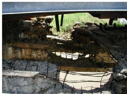
写真 2-6 桁の一部が破壊された様子
