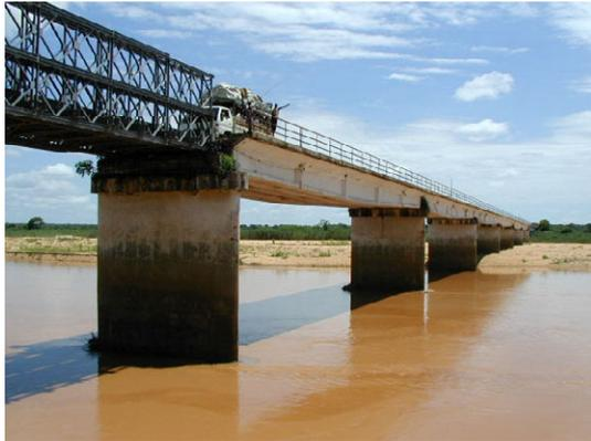
写真 2-1 右岸側に設置された仮設橋
