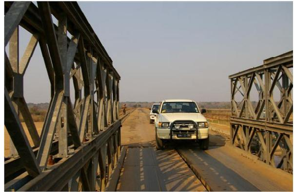
写真 2-2 仮設橋（1車線）を通行する車両
