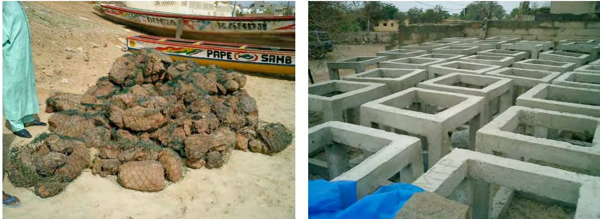
Figure 5-8 Gabions (gauche) et blocs en béton (droite)
