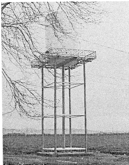
写真-26 高架タンク (Nazarov irrigation pump station)
