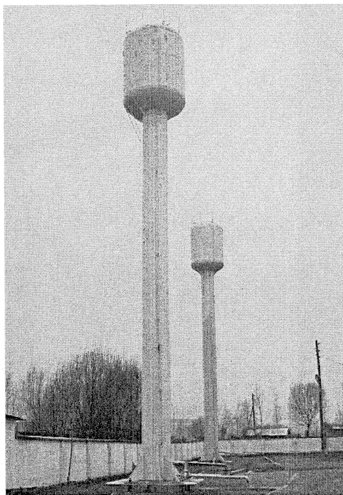
写真-27 高架タンク (Rehabilitation of Water Supply System in Sovietski District Center、河川の伏流水を水源としている)
