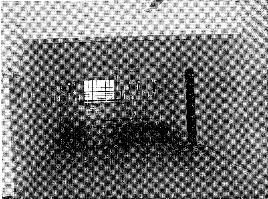
写真一 16 ろ過場内部
