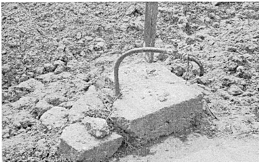
写真－８ 屋敷内に設置された給水栓
