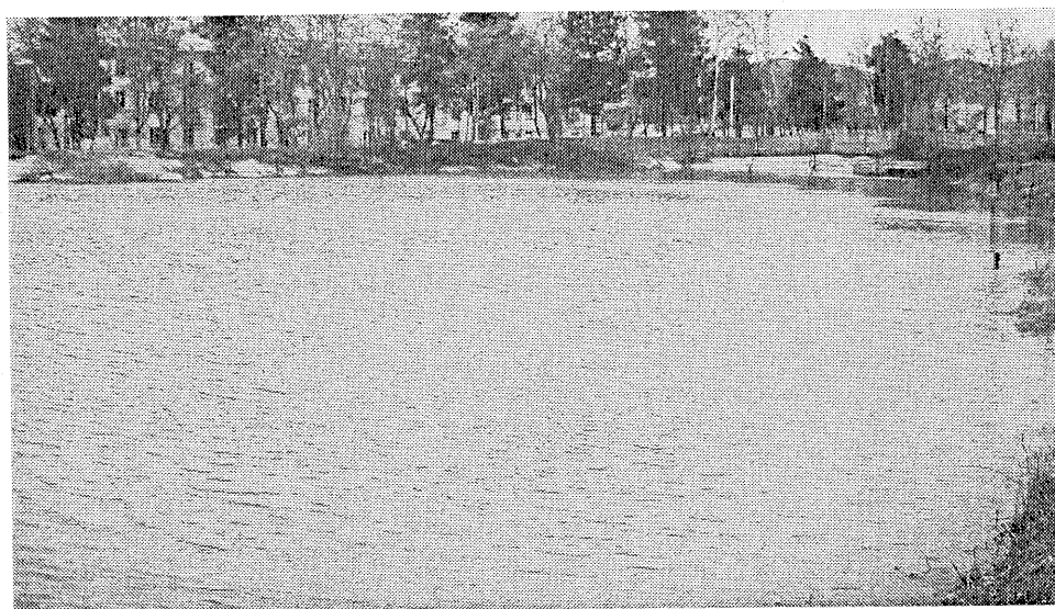
写真一 12 沈殿池全景
