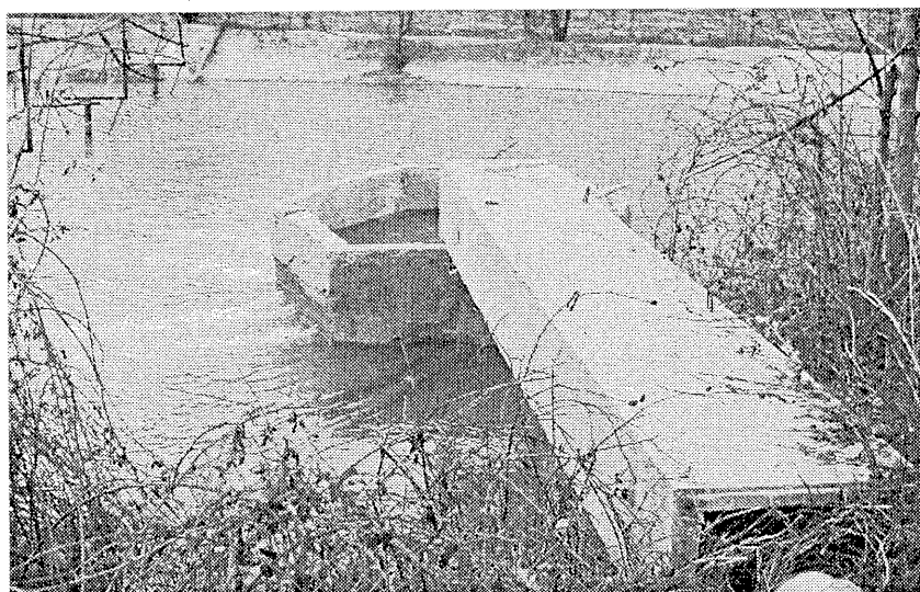
写真一 11 沈殿池流入部（サイホンでここに導水される）
