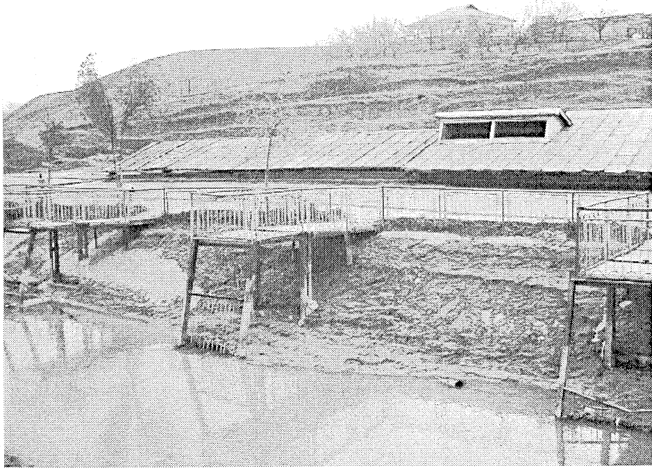
写真一 第1揚水機場
