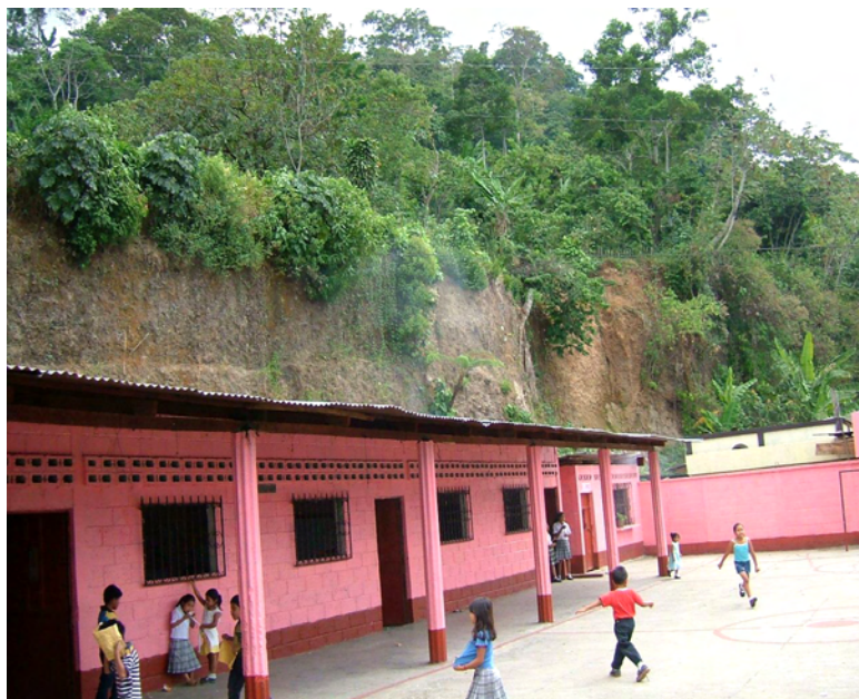
2.教室遠景 (教室後部の斜面崩壊危険あり)
