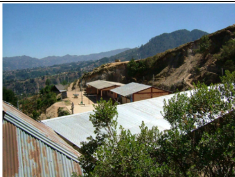
1. 教室遠景 (手前右は建設中3教室校舎)
