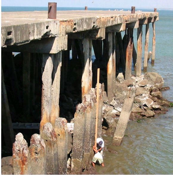
Foto 8-9 Instalando el medidor de la marea
