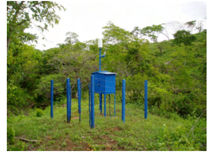
Foto 8-6 Pluviómetro y sensor de nivel de agua telemétrico
