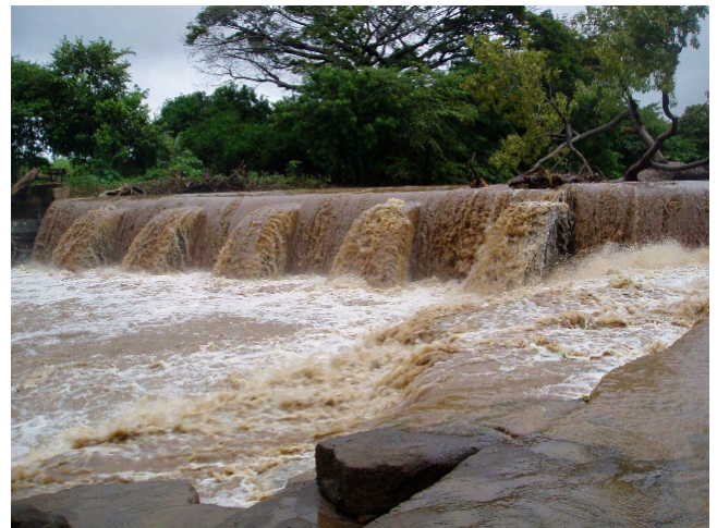
Foto 8-3 Presa de Masachapa en la época lluviosa
