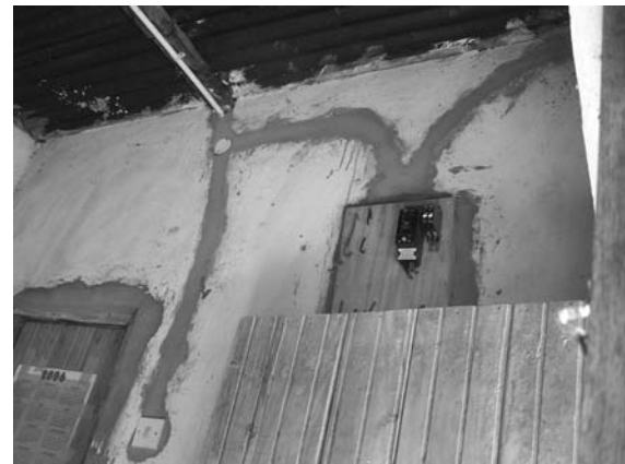
Nyambi 商店内部 電化に備えて屋内配線工事を既に済ませている。
