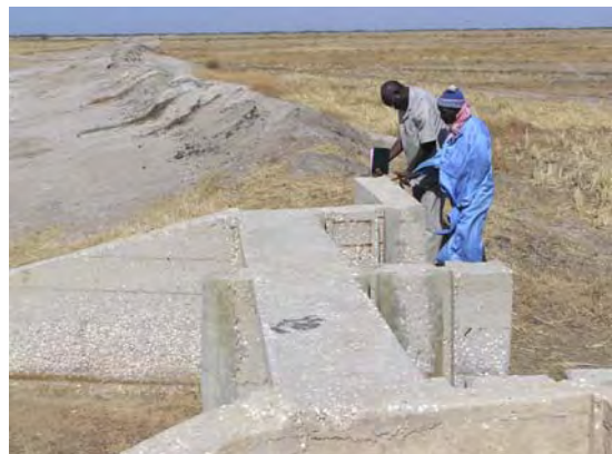
Digue contre la salinisation (région de Fatick)
