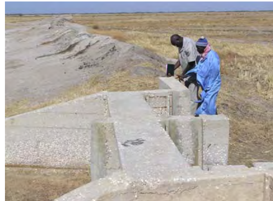
塩害防止用の土堰堤（ファティック州）
