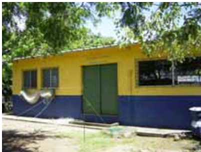
ピラジータ種苗生産施設外観
