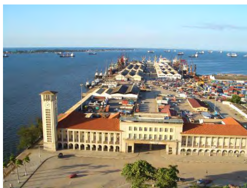
Cais de Cabotagem e Terminal de Carga Geral
