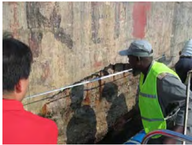
Deterioration Survey (Port of Lobito)
