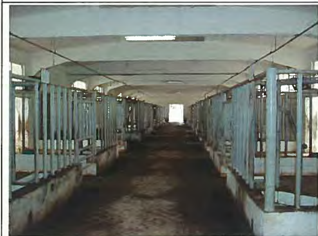
写真3：モンカダ人工授精センター（第1牛舎） 補強された柵と滑り止め
