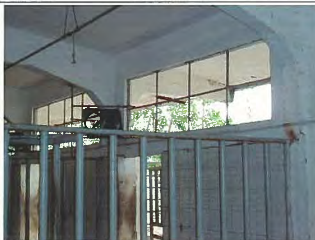
写真4：モンカダ人工授精センター（第1牛舎） 細霧装置とファンにて暑さ対策を行う。
