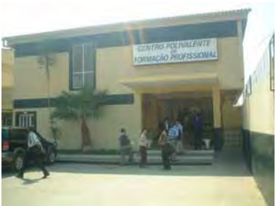
13.ポリテクニックセンター （本館・2階は宿泊施設）
