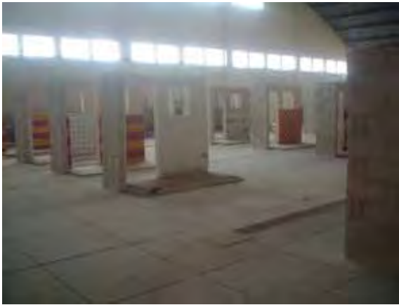
9.カゼンガセンター（実習場・タイル貼り）
