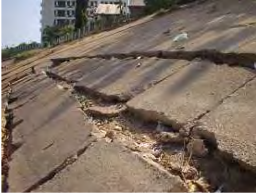
写真 2.1.3(2/2) ヒマワリホテル上流の護岸工の状況(2/2)
