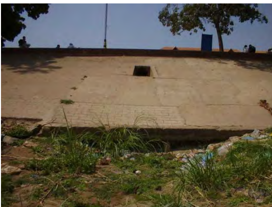
写真 2.1.9 修復された護岸工法面の状況(王宮より上流)を正面から望む
