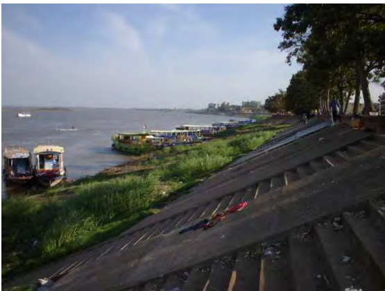
写真 2.1.7 王宮より上流の護岸工の状況
