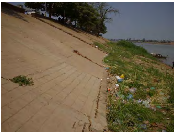
写真 2.1.8 修復された護岸工法面の状況(王宮より上流)
