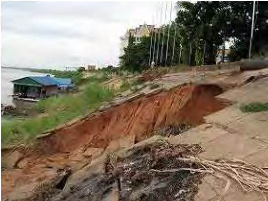
写真 2.1.4(2/2) ヒマワリホテル上流からチャトムック国立劇場裏の護岸工の状況(2/2)
