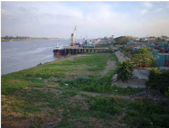
写真 2.1.19 国際港上流の堤防区間
