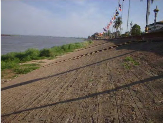
写真 2.1.6 王宮前付近の護岸工の状況
