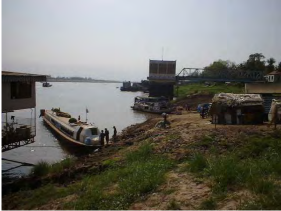
写真 2.1.18 国際港下流の堤防区間
