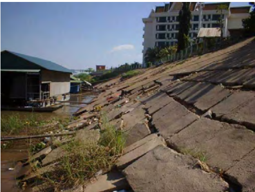
写真 2.1.3(1/2) ヒマワリホテル上流の護岸工の状況(1/2)
