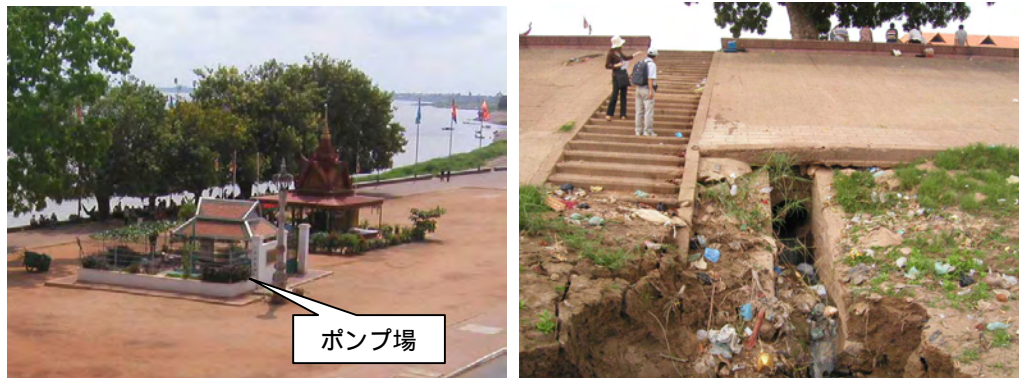
写真 2.1.2 既設 3 号ポンプ場とその吐出口の現況
