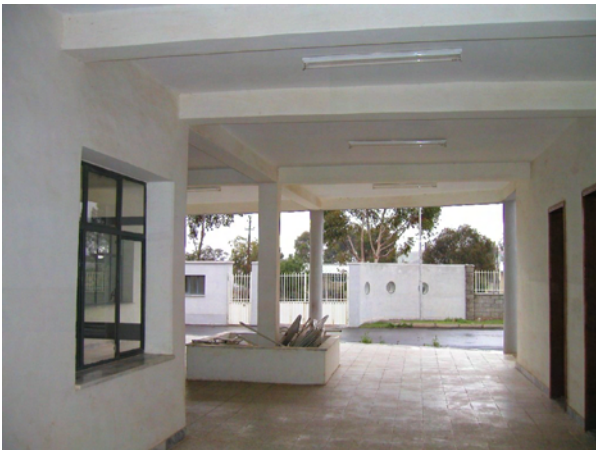
病院の正面建物から裏手の様子
