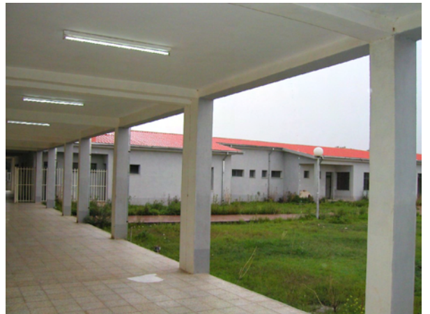
管理棟の廊下から見た診療棟の外観
