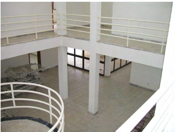
管理棟の 2 階の回り廊下から、1 階の内部
