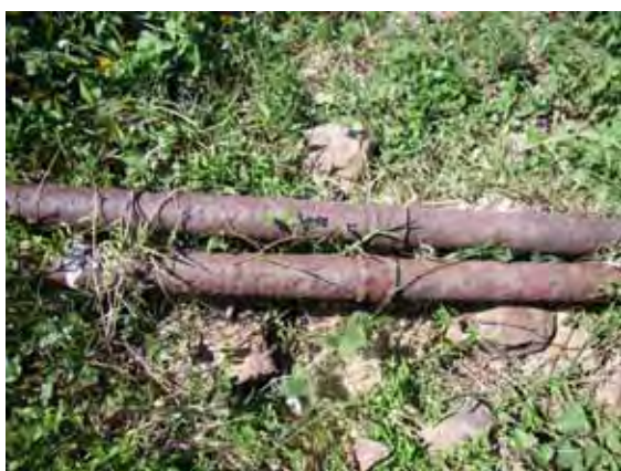
劣化した取水管
