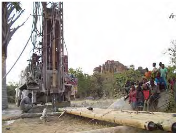
掘削機の設置
