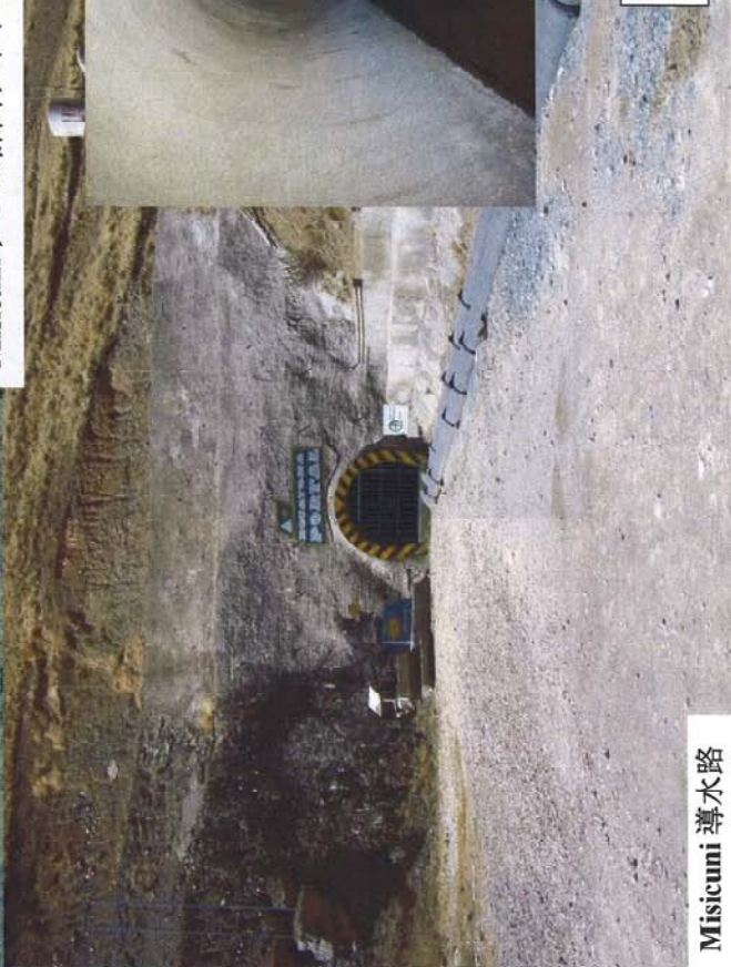
Cala Cala 浄水場へ原水を 送水する仮設管路
