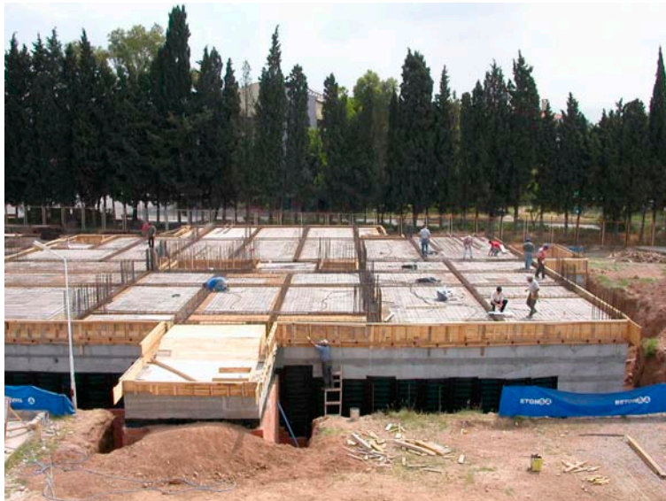
教員養成センター 建設風景 (イズミール校敷地内)
