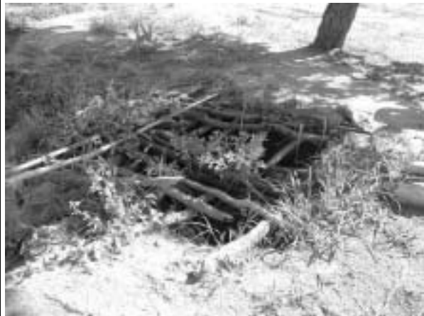
排水浸透施設は素堀孔
