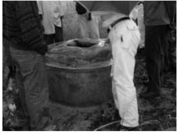
コンクリートライニングを施された DWA 仕様の浅井戸
