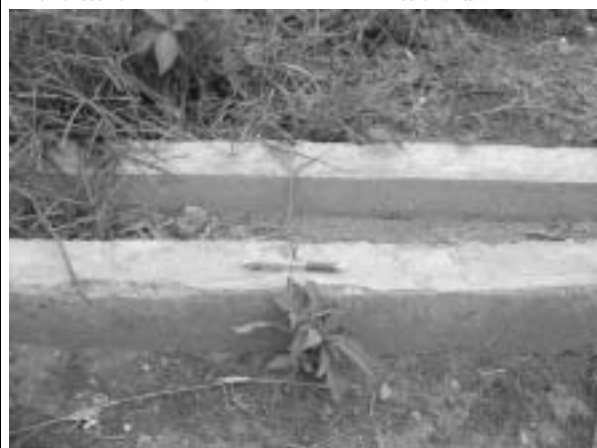
排水路に生じたクラック、概してコンクリートの品質は低く、無筋のためもあるクラックが多い。
