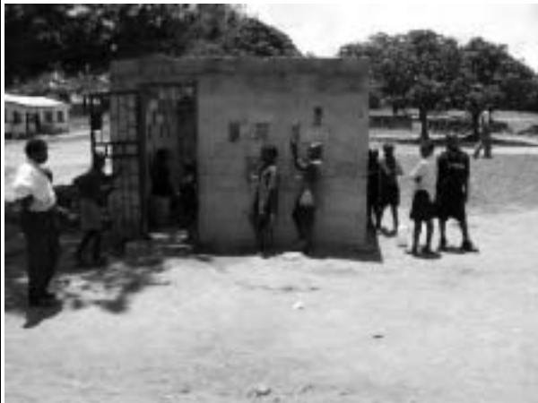
学校側がポンプ小屋を建設
