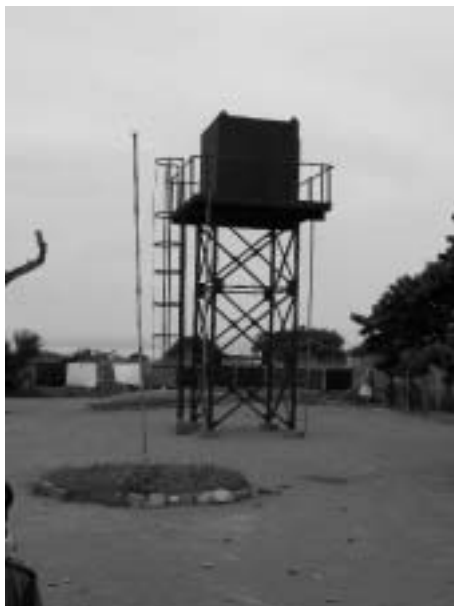
レベル - 2 施設施工中、配管工事待ち
