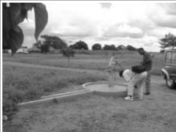
地下水枯渇により放置されたままの給水施設
