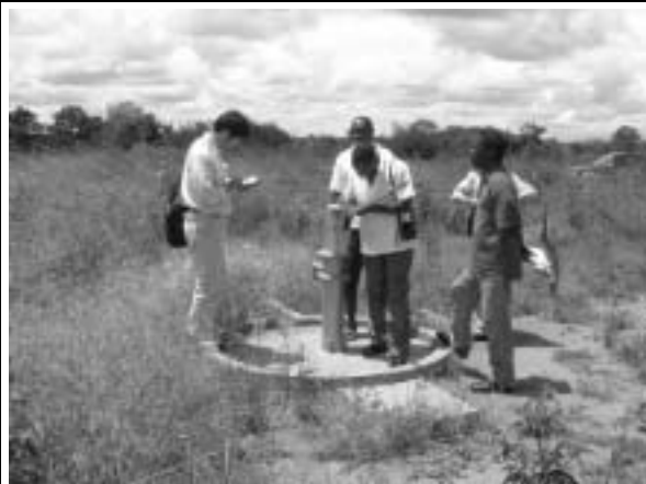
ハンドルが上がったまま故障した給水施設
