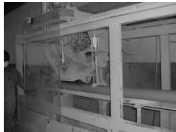
スクリーンパイプスリット加工
