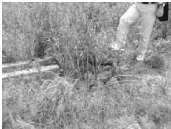
排水末端は素掘孔に巨礫をいれてある
