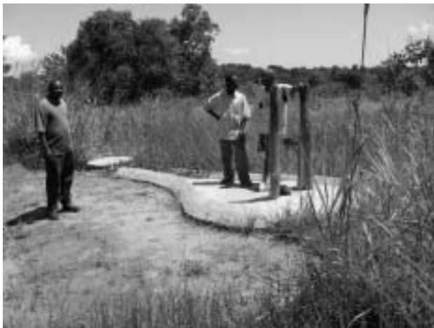
Irish-Aid 資金による深井戸（1993 年施工） シリンダー バケツによる取水、故障、北部州 Chinakila R.H.C、 2006 年 3 月 12 日撮影
