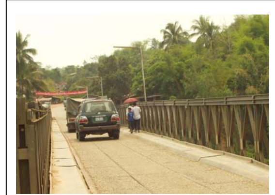
写真-4：既設橋梁は幅員が狭く、一方向のみ通行が可能。歩行者との接触事故もある。
