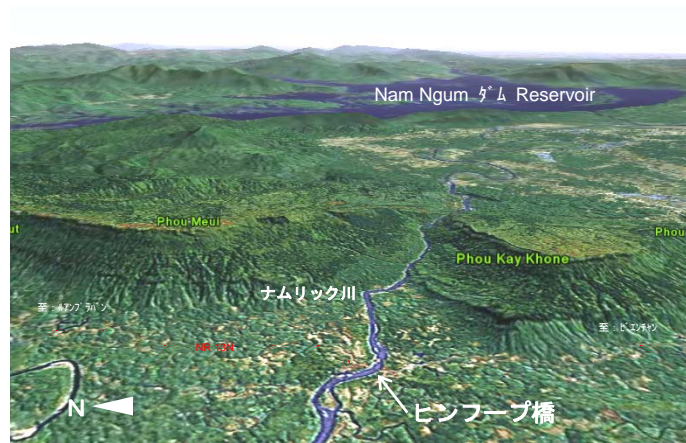
図 2.2.1 対象地域付近の地形状況
