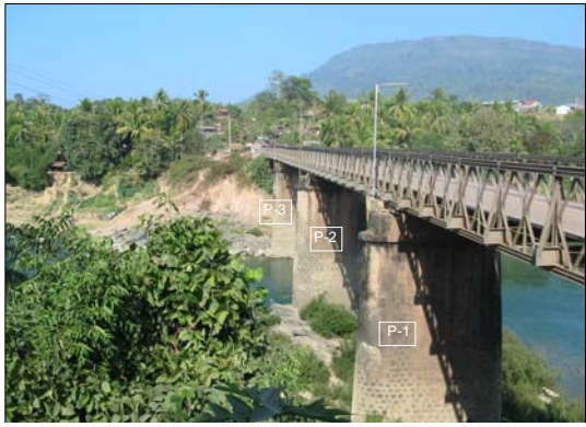
写真-1：上流側右岸からみた既存ヒンフープ橋の現況（上部：ベイリー橋、橋脚：練石積）
