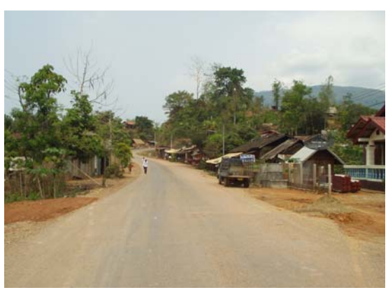
写真-12：既設橋梁左岸側接続道路（国道 13 号 N）の状況。DBST（簡易舗装）で舗装。
