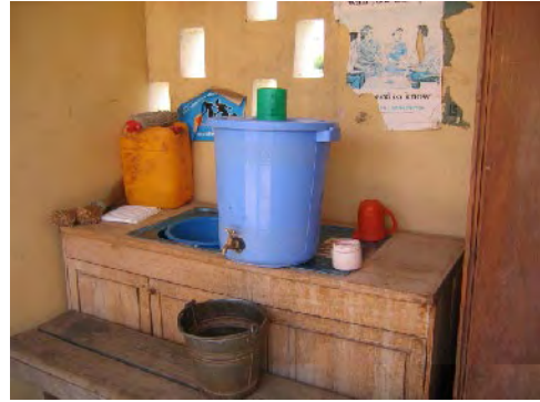
ジラバ郡 ウロ保健所 水タンク：各保健所で使用されているタンク
