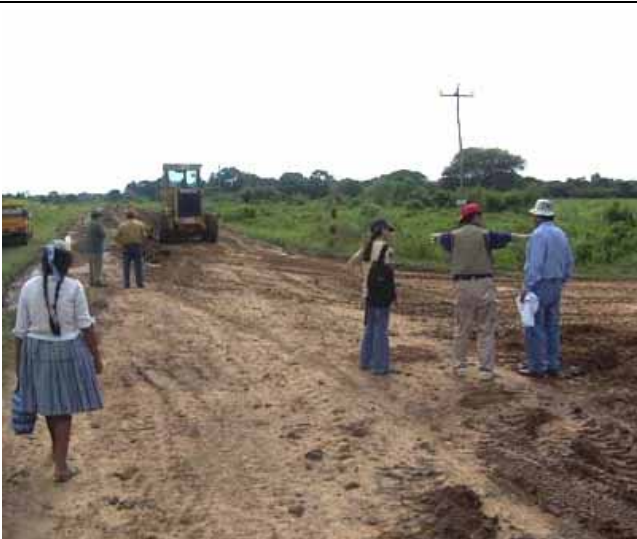
【サンタクルス県】 地方道路拡充現場
