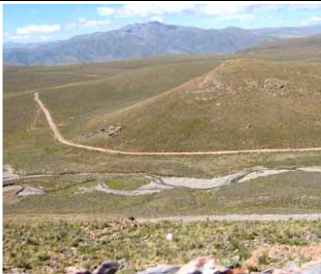
【ポトシ県】 国道へつながる整備後の地方道路全景
