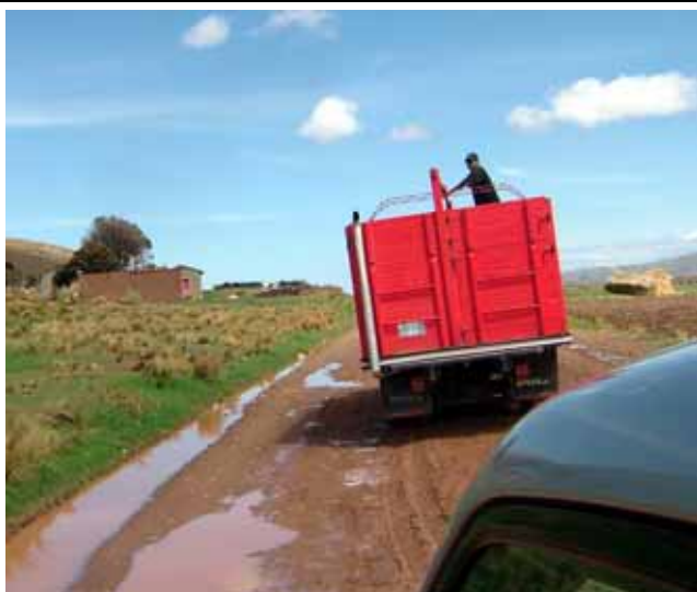
【ラパス県】 整備前道路での農産物輸送 (走行性悪く移動時間もかかる)
