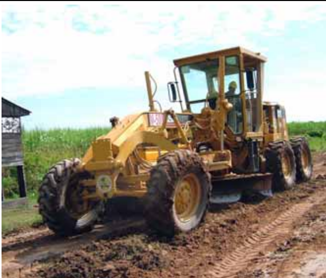
【サンタクルス県】 地方道路拡充工事開始直後の現場
