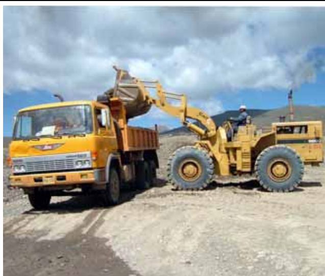
【ラパス県】 日本の供与機材を使用しての砕石積込作業
